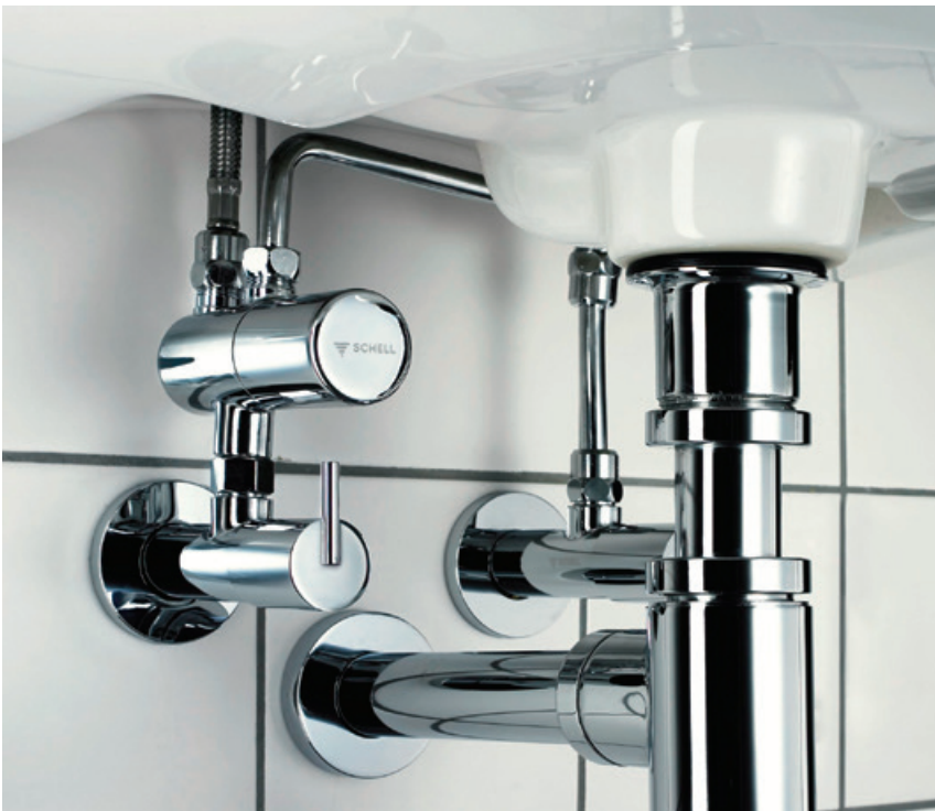
Abb. 3: Sind an Eckventilen oder in Waschtisch-Armaturen Thermostate zum Schutz der Nutzer installiert, so muss die Probenahme sowie die Ermittlung der Systemtemperatur im Rahmen von Legionellenuntersuchungen unbedingt vor den thermostatischen Einrichtungen erfolgen.
