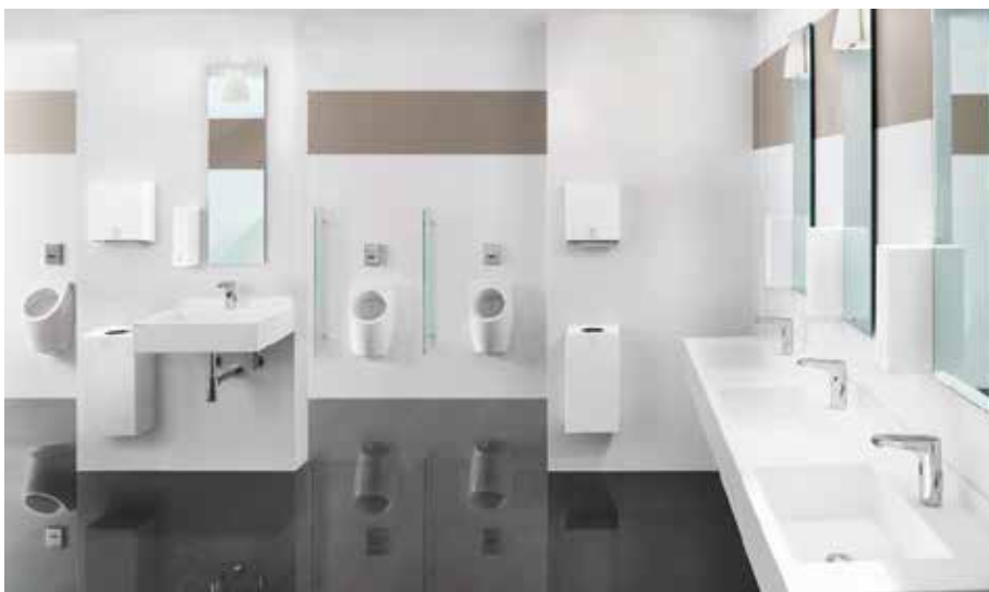
Abbildung 4: Die Ansprüche an Armaturen in öffentlichen, halböffentlichen und gewerblichen Sanitäreinrichtungen sind hoch; sie müssen robust sein und den hohen Anforderungen standhalten. Mit berührungsfreien, infrarotgesteuerten Armaturen können im Vergleich zu Standard-Einhebelmischern bis zu 62 Prozent Wasser eingespart werden.
