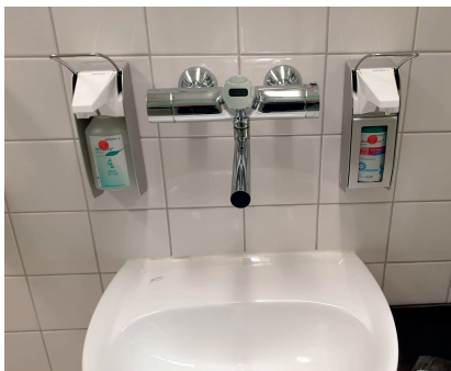
Bild 2: Berührungslose Waschtischarmaturen senken das Risiko von Kreuzinfektionen von Mensch zu Mensch. Über die Nachlaufzeit verbessern sie die „Siphonhygiene“, da Seifen- und Essenreste wirkungsvoll ausgespült werden, selbst wenn der Nutzer den Waschplatz bereits verlassen hat. Foto: Schell
