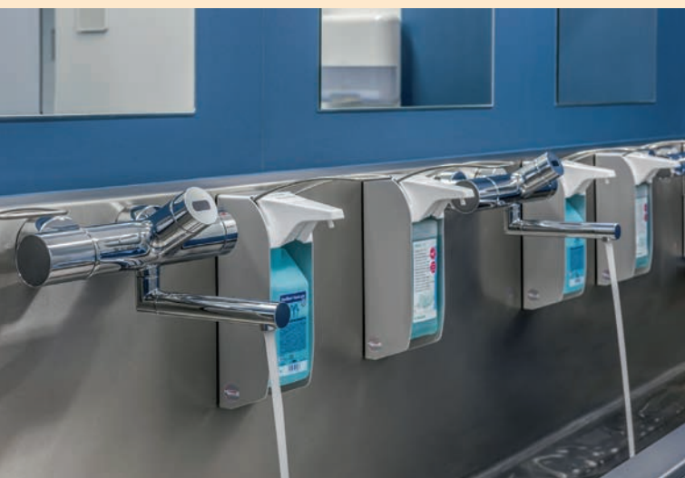
Die Aufputz-Waschtisch-Armaturen ‚Vitus E-T‘ mit Thermostat und Verbrühschutz sorgen für berührungslose Hygiene. Hautkontakt ist weder beim Ein- noch Ausschalten notwendig.
