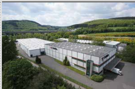
Production et centre logistique
