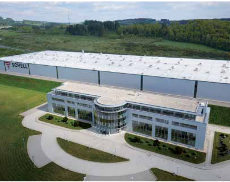
Fabriek 1 Productie met administratief gebouw en opleidingscentrum
