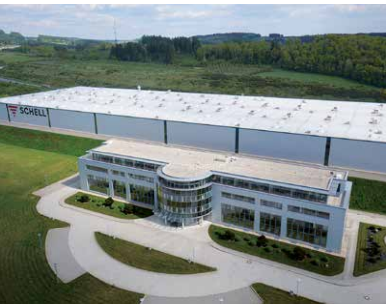
Stabilimento 1 Produzione con edificio amministrativo e centro di formazione
