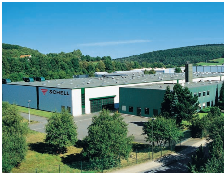
Zakład 2 – hala produkcyjna z centrum logistycznym
